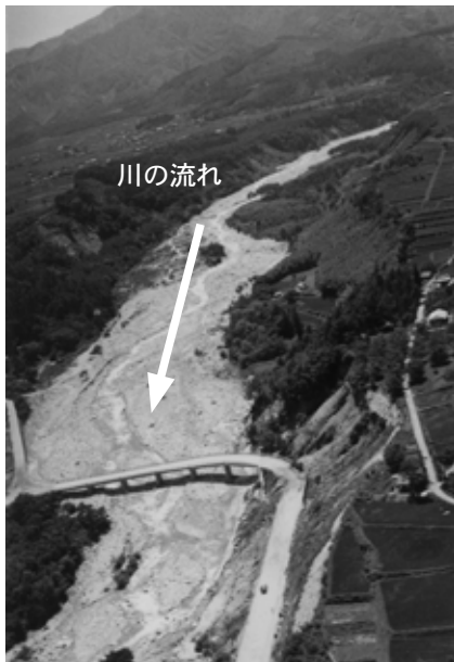
▲与田切川国道153号付近
