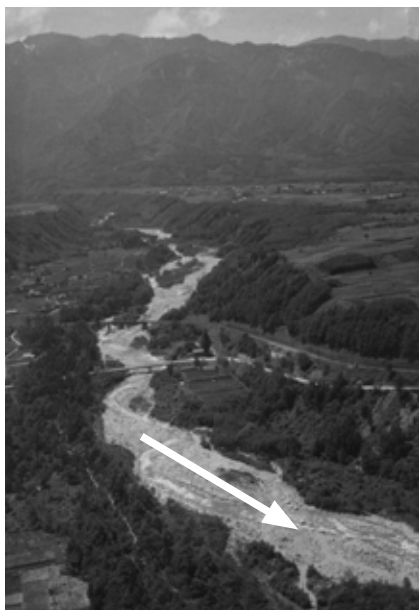
▲中田切川国道153号付近
