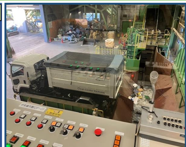
回収して運ばれてきた不燃ごみを投入しています。その後、不燃ごみと粗大ごみを破碎機へ送り込みます
