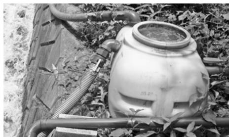
砂沈殿槽
