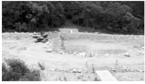
工事中の帯工
