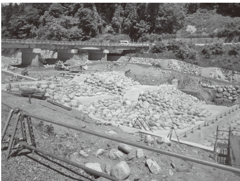
国道下 平成29年12月完了予定
