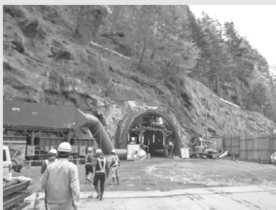
工事用トンネル（中川村）
