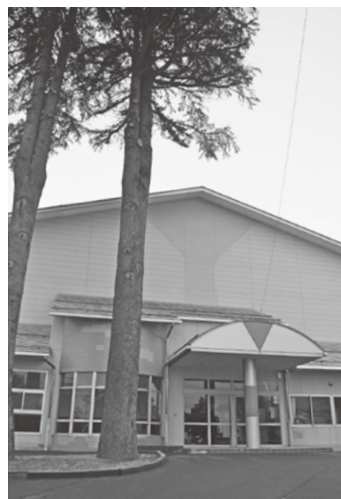
七小樹木の枝落下現場
