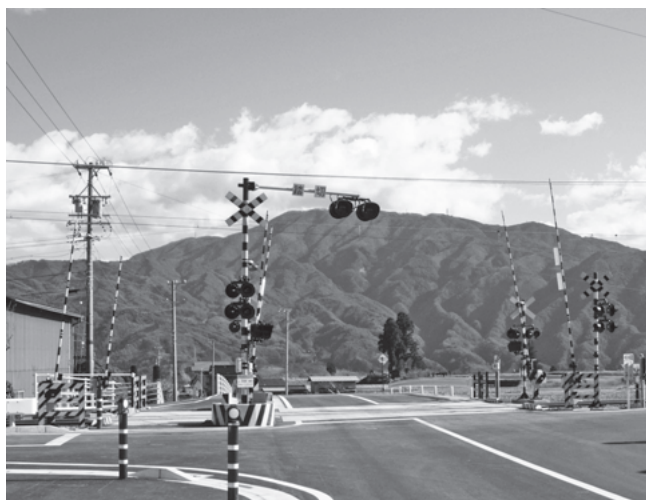
完成した堂前線赤坂第1踏切
