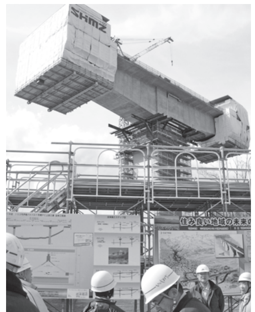
進む国道バイパス工事
