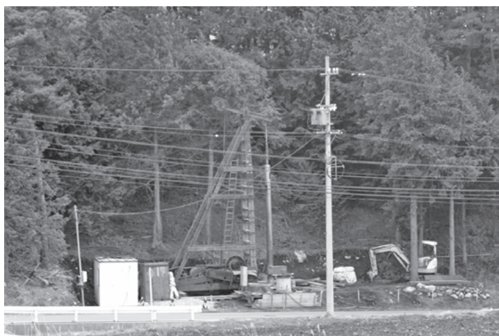
掘削中の深井戸工事現場
