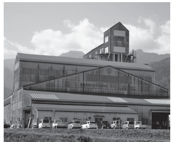
飯島カントリーエレベーター
