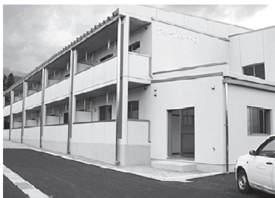
完成したグリーンハート
