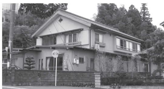
障がい者のグループホーム(松川町)
