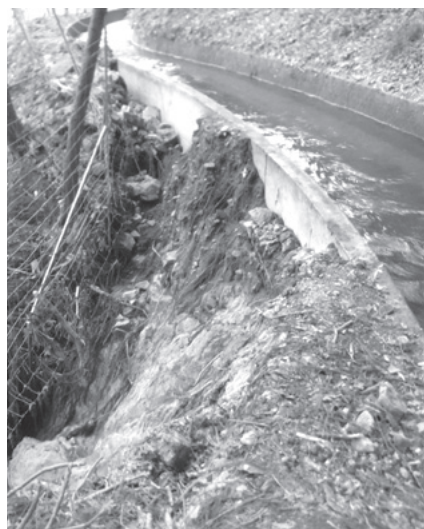
改修を待つ新井用水(2018)
