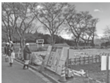
建設が進む観光拠点施設
