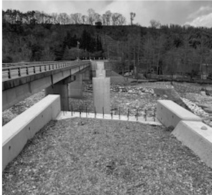
順調に進む歩道工事
