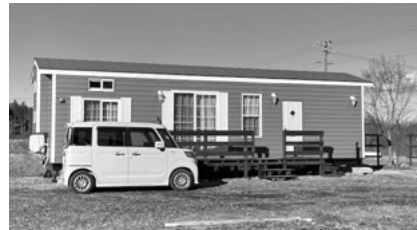
移動できないトレーラーハウス
