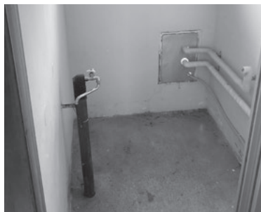
浴室床はコンクリートむき出し。建設当初から今も入居者が自分で、風呂釜を持ち込む。
