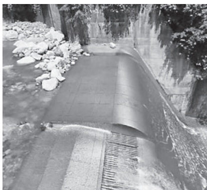
7月末の与田切発電所の取水口
