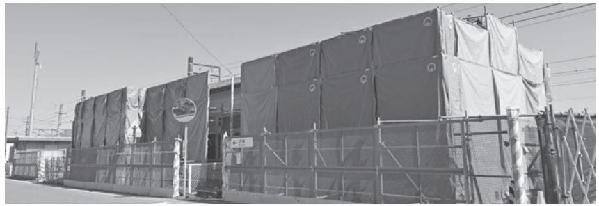
解体工事がすすむ七久保駅
