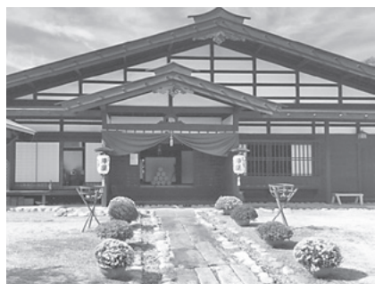
修理を待たれる飯島陣屋
