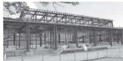
建設中の給食センター
