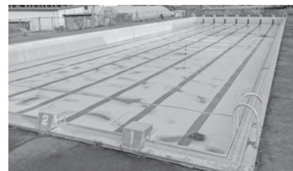
中学校のプール
