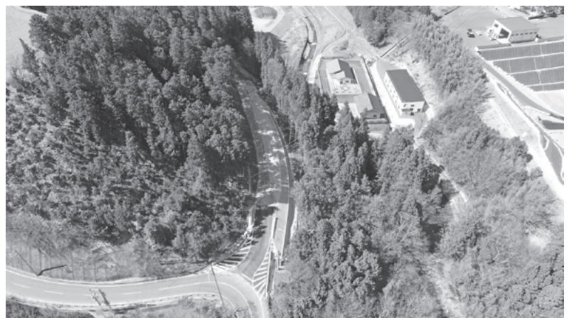
拡幅中の南田切線
