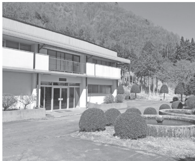
土砂災害特別警戒区域にある樽ヶ沢浄水場
