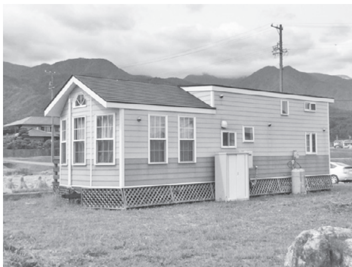
ワーケーション用のトレーラーハウス(類似品)
