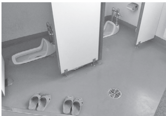
和式トイレの改修を
