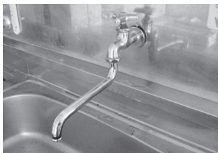
自在水栓（施工前）
