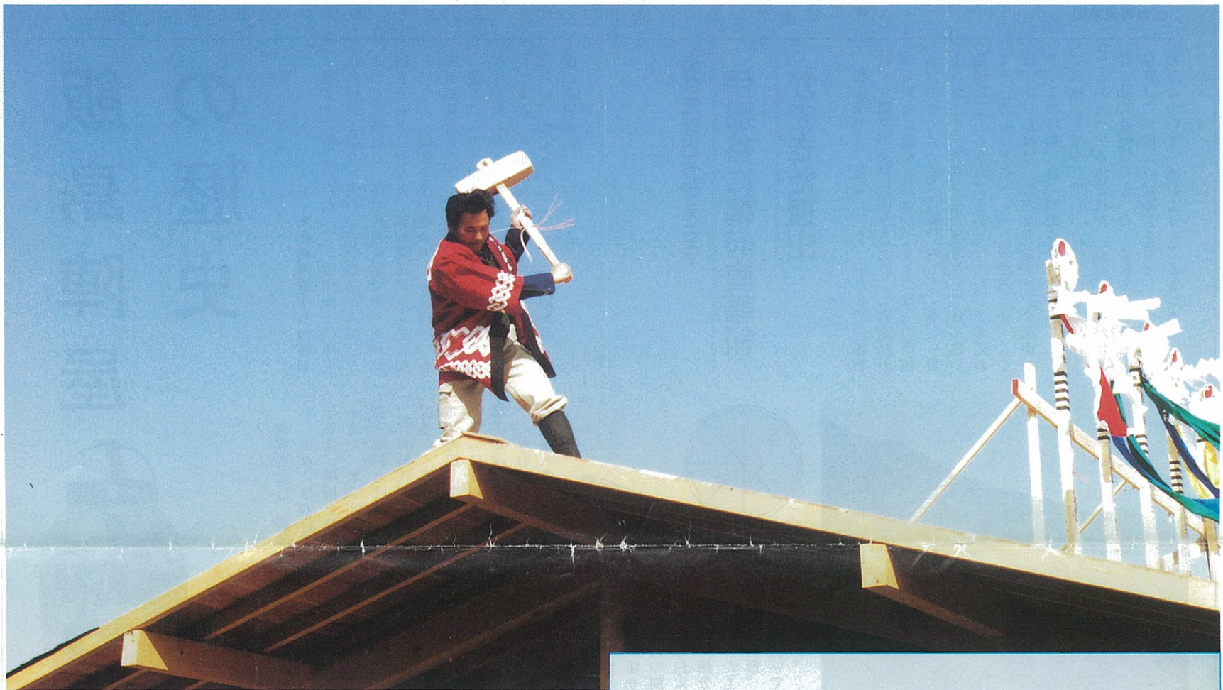
飯島陣屋上棟式 (1993.3.17)
