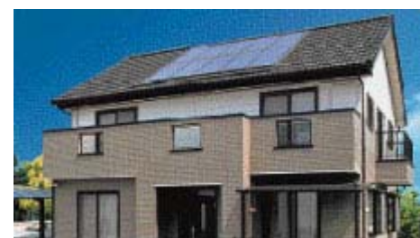
ソーラーハウス（給湯・床暖房システム）
