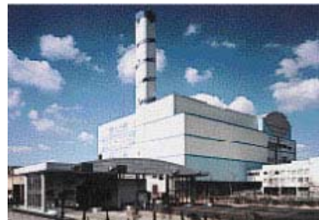
ごみ発電施設皇后崎工場（北九州市）
