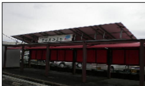
図 7.2.1-2 野洲市 太陽光発電システム
