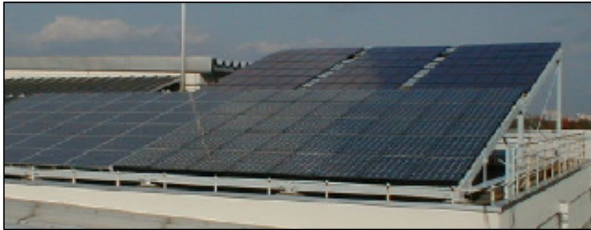
図 3.1.1-3 架台設置型
