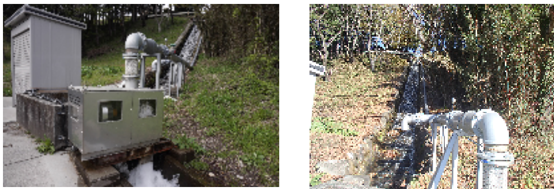
図 3.1.5-2 町内水力発電 2\text{kW}
