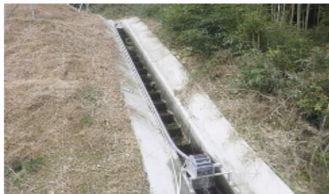
図 3.1.5-3-2 山口県田布施町小水力発電設備
