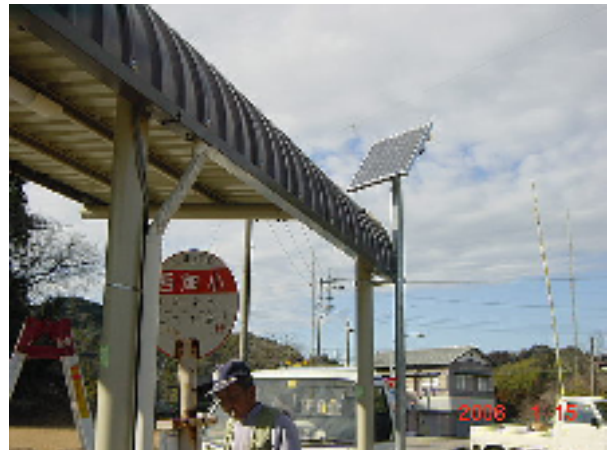
図 3.3.4-1 製作風景と手作り街路灯（千葉県大多喜町）
