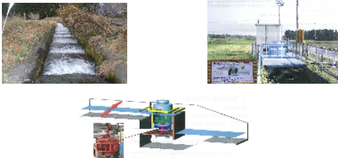
図 3.1.5-1 農業用水路にミニ発電機導入事例
