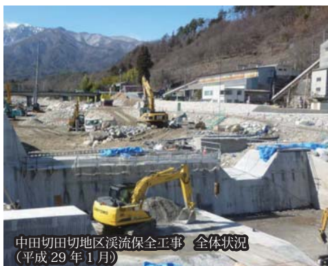
中田切田切地区溪流保全工事 床固め (平成29年1月)
