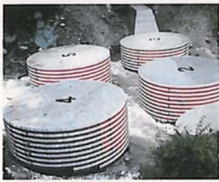
鋼製セル式砂防堰堤
