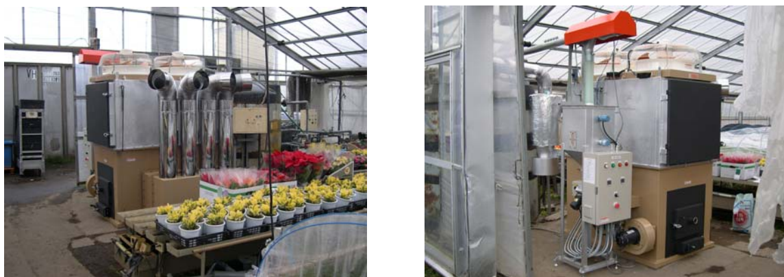
図 7.1.8-3 ペレットボイラ（温風）
