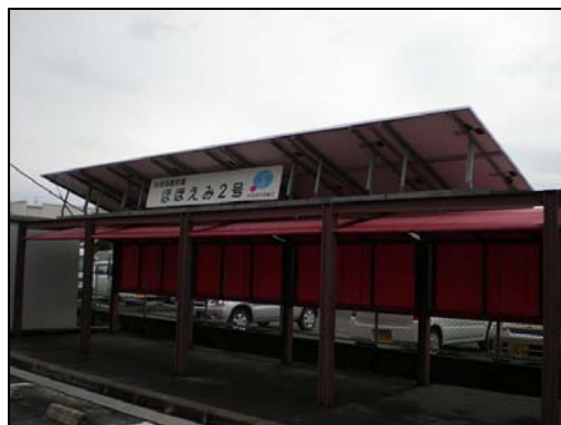
図 7.2.1-2 野洲市 太陽光発電システム
