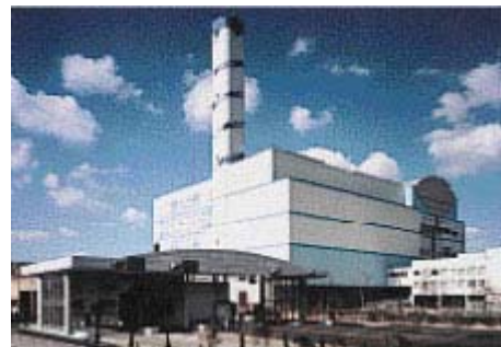
ごみ発電施設皇后崎工場（北九州市）
