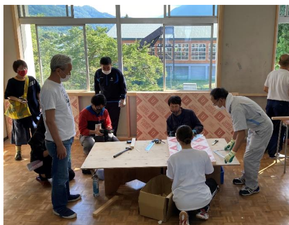
図 11 壁に貼る断熱材をカットしている様子
