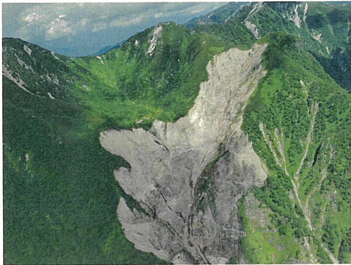
クラック発見直後の全景 令和4年8月3日撮影
