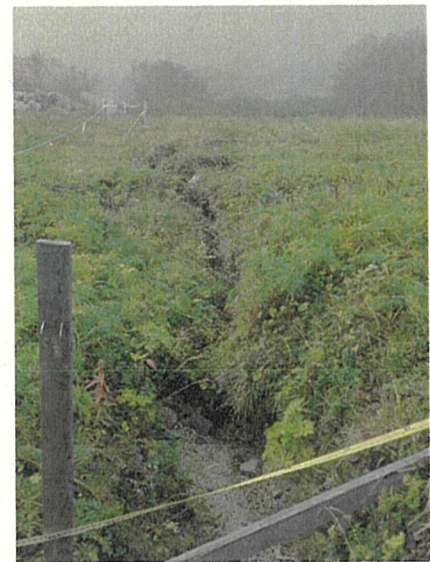
クラックの状況 令和6年9月28日撮影
