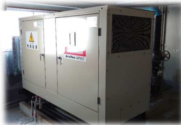
写真 3-10 非常用自家発電設備
