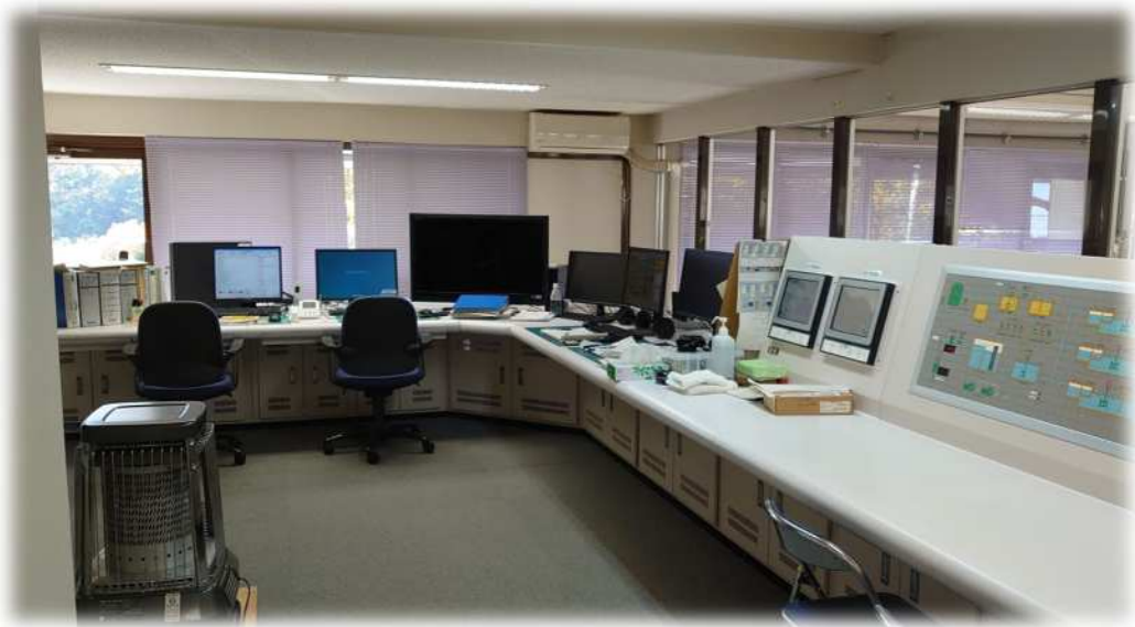
写真 3-5 樽ヶ沢浄水場中央監視室
