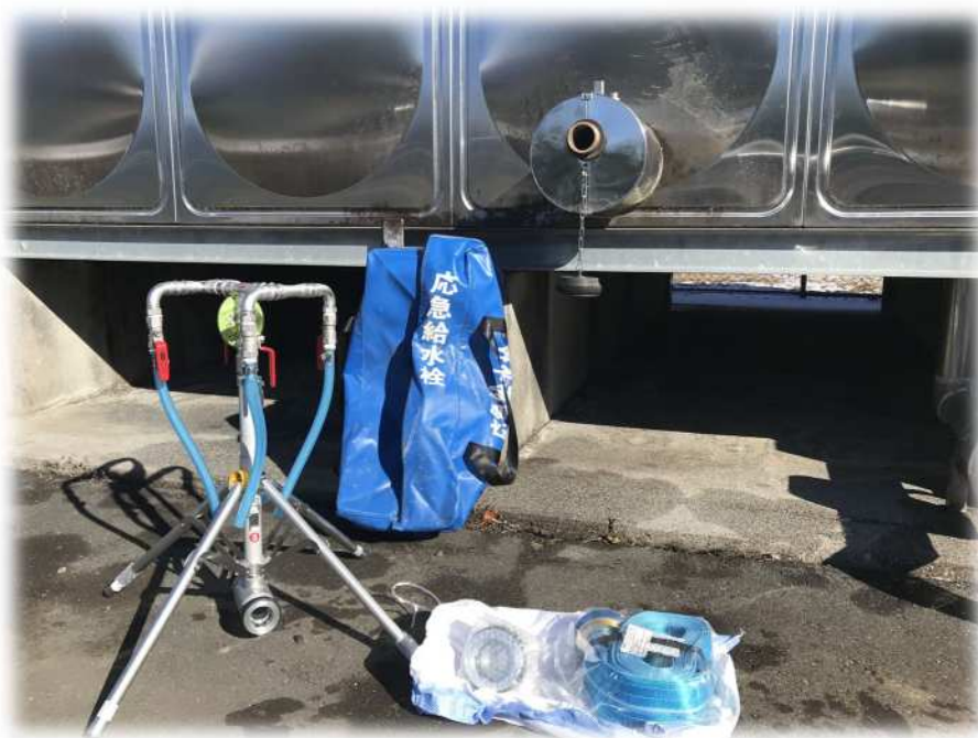
写真 6-1 応急給水設備
