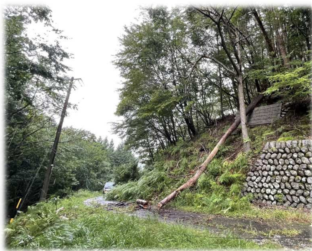
写真 6-2 倒木による道路遮断と停電
