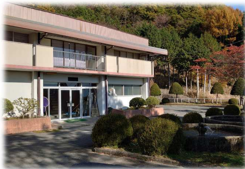
写真 6-3 樽ヶ沢浄水場管理棟
