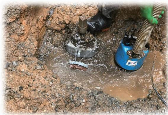
写真 3-8 管路からの漏水状況
