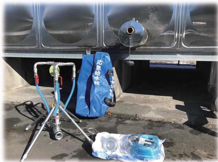
写真 6-1 応急給水設備
