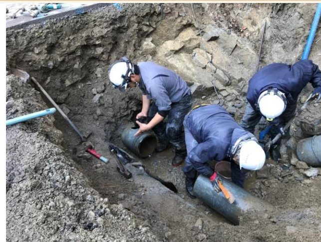
導水管の漏水箇所修理中
